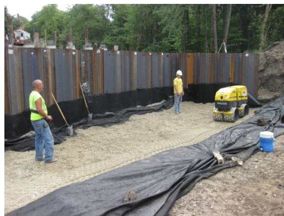
b.) Vibratory compaction
