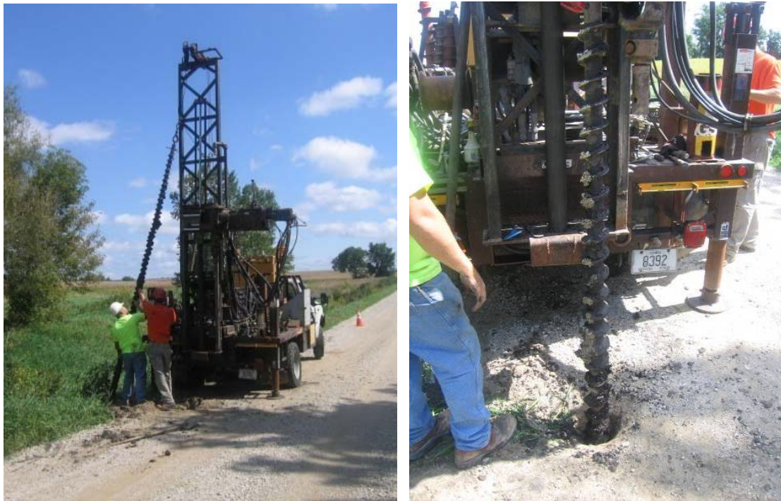
a.) Drilling rig
